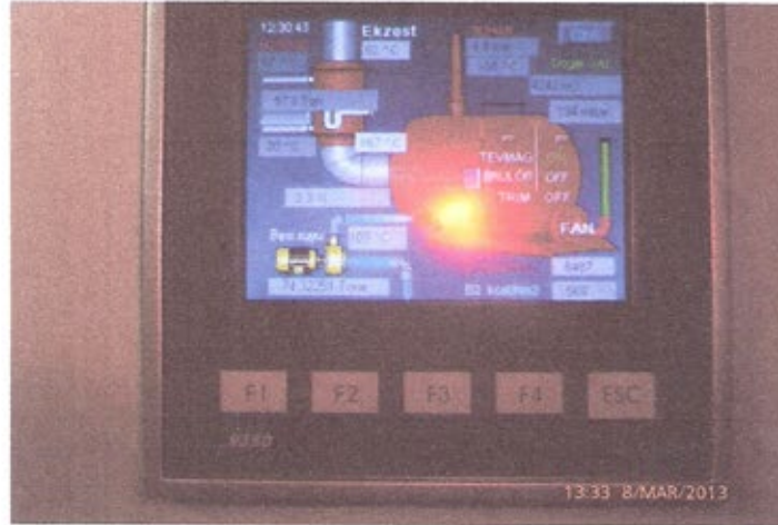
Şekil 2. TEV-MAG01 SCADA Sahada İzleme Sistemi
